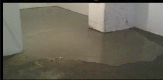
Nivelación del pavimento ARDEX IFS MIX. En capa de 15mm.
