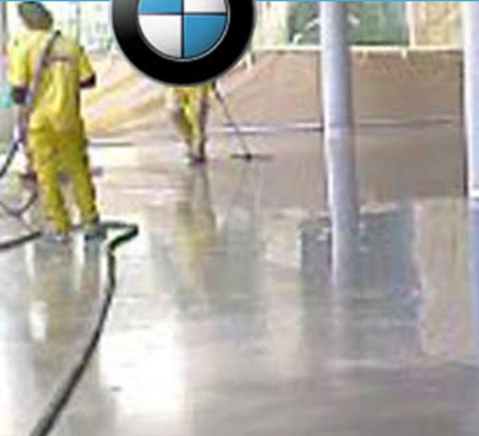
Reparación del pavimento con **ARDEX A45**, colocación de perfiles de aluminio y reparación con **ARDEXFIX**. Imprimación con **ARDEX EP2000** y posterior arenado a saturación. Nivelación del suelo con **ARDEX IFS** (aspecto aguas) y sellado.
